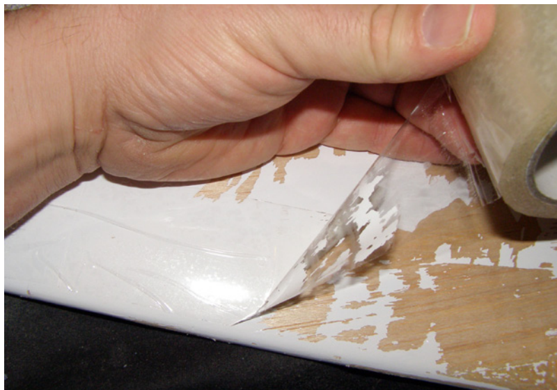
Mit Klebeband ließ sich die alte Farbe sehr gut lösen, ohne vom Holz zu viel abzutragen, wie das beim Schleifen der Fall gewesen wäre
