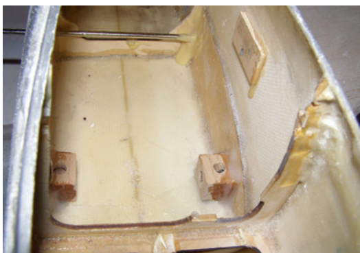
Auch der Innenausbau der Bobcat wurde überarbeitet und schadhafte Stellen repariert
