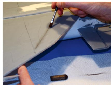
Alterung und Weathering wird mit Pastellkreide, die auf 400er Schleifpapier zerrieben wird, aufgetragen. Am besten eignet sich dafür ein geringfügig breiter Pinsel
