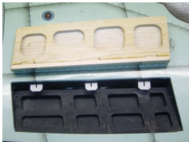
Das Öffnen der inneren Vollbeplankung der Landeklappen fördert interessante Details über ihren inneren Aufbau zutage
