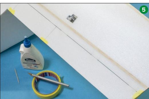
5 Natürlich härtet der Weißleim jetzt nicht spontan aus, daher lässt man die Klebstellen über Nacht in Ruhe stehen. Für eine exakte Einhaltung der Ruder-Neutralstellung sollte man alles mit Lackierklebeband fixieren. Gut zu erkennen ist ein überall gleichmäßiges Spaltmaß von unter 1 Millimeter
