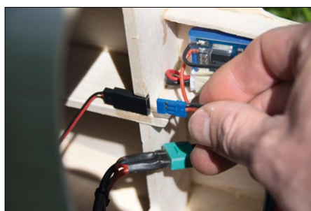
Abbildung 4: Anschluss zur ersten Inbetriebnahme
