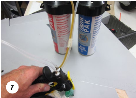
Über die Löcher kann der Schaumkleber gezielt eingeführt werden
