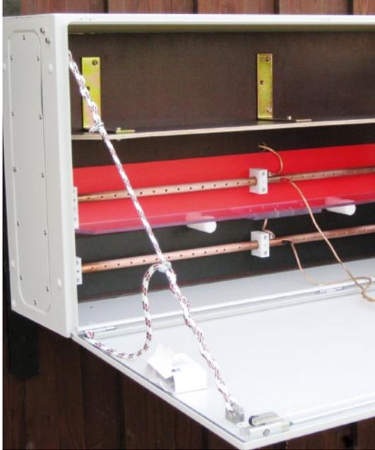
**12-Volt-Ladeschiene. Es empfiehlt sich eine Barriere zwischen Plus- und Minusschiene einzubauen, die versehentliches Kurzschließen verhindert**
