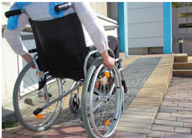
Eine bauliche Maßnahme für den barrierefreien Zugang ist der stufenlose Eingang
