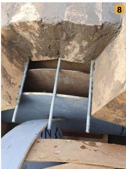
Als Abzug dient ein einfaches Ofenrohr aus dem Fachhandel. Um es an der Basis abzustützen, habe ich eine Konstruktion aus drei waagrecht und teilweise im Eingangsgewölbe vermauerten, verzinkten Gewindestangen umgesetzt
