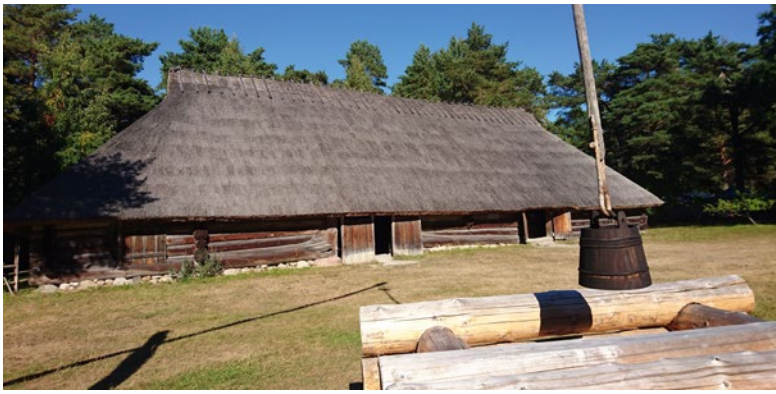
In solchen Rieghäusern wurde früher Brot und eingelagertes Getreide automatisch mitgeräuchert
