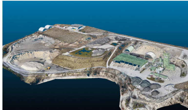
Aus den per Drohne gewonnenen Daten lassen sich 3D-Ansichten erstellen, mit denen die Projektplanung beschleunigt und damit kostengünstiger wird
