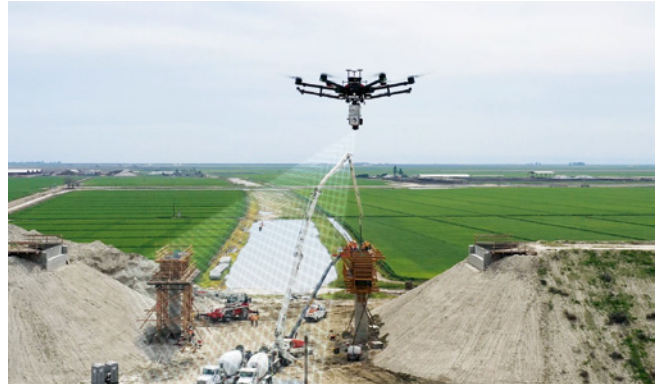
Im Rahmen der Arbeiten an der A6 in Süddeutschland hat die Hochtief AG ein Pilotprojekt gestartet und Drohnen mit Laserscanner-Technik eingesetzt
