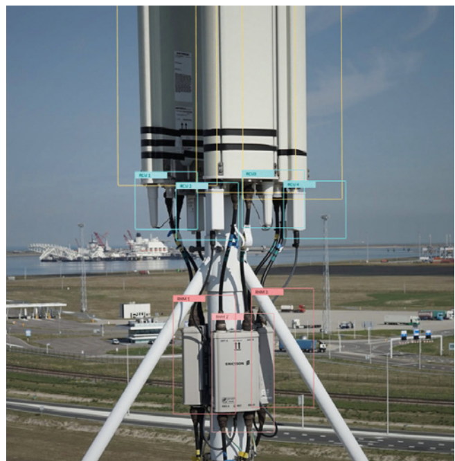
Die Kamera ist in der Lage, an komplexen Bauwerken oder technischen Anlagen verschiedene Komponenten zu erkennen und zu benennen
