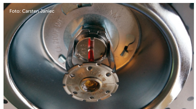
Wer größere Mengen Lithium-Akkus lagert, sollte neben einer Brandmelde- auch in eine Sprinkleranlage investieren
