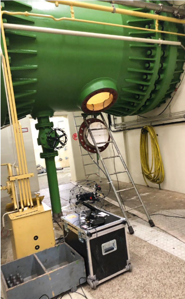
Durch diese enge Luke mussten sich früher Industriekletterer zwingen, um die Kraftwerksrohre zu inspizieren. Heutzutage übernehmen Drohnen wie die Elios 2 den Job
