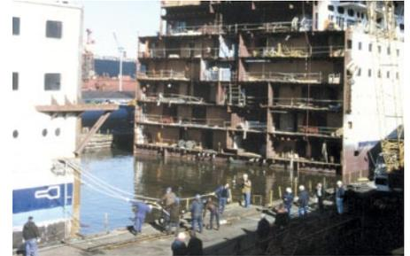
**Die Profis am Werk. Schiffsverlängerung in Bremerhaven. Tausende Leitungen müssen wieder verknüpft werden. Es klappt.**
