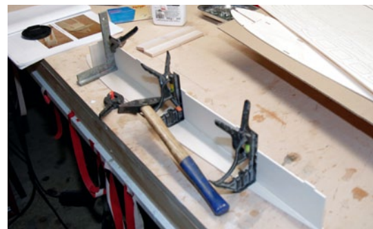
Begonnen wird mit dem Verkleben von Motorspant, rechter Mittelrippe und Kabinenboden
