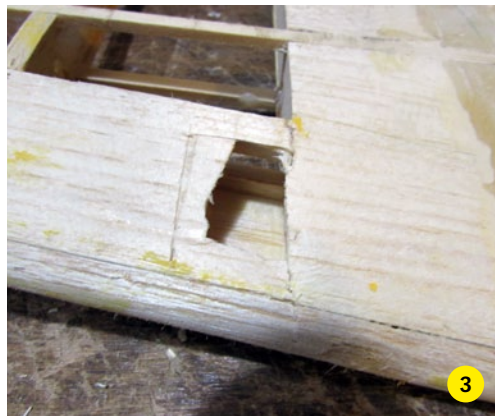
Der Ausschnitt für die Reparaturstelle wird festgelegt
