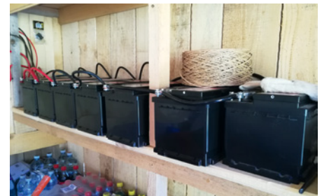
Über einen Solarregler wird diese leistungsfähige Bleiaku-Bank mit 560 Ah geladen. Einzig die maximale Belastbarkeit ist von den Nutzern zu beachten
