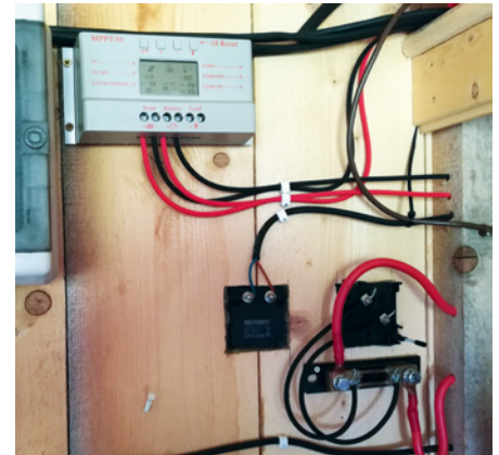
Über einen Solarregler wird diese leistungsfähige Bleiaku-Bank mit 560 Ah geladen. Einzig die maximale Belastbarkeit ist von den Nutzern zu beachten
