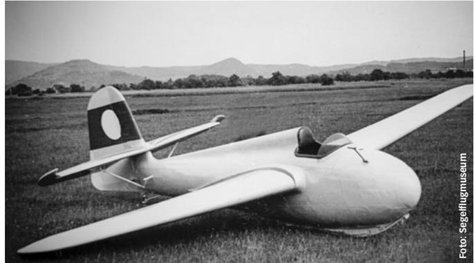
**Mit Stummelflügel ausgerüsteter 6-m-Habicht, der Piloten als Trainingsflugzeug der Me-163 dienen sollte**
