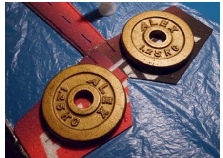
Beim Einkleben der Versteifungen ist immer darauf zu achten, dass die Bauteile gerade bleiben. Beim Beschweren können die Gewichte nicht zu groß sein
