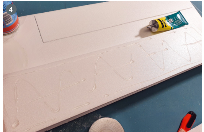
Mit Uhu Por werden die KF-Profilstufen auf die Grundplatten geklebt
