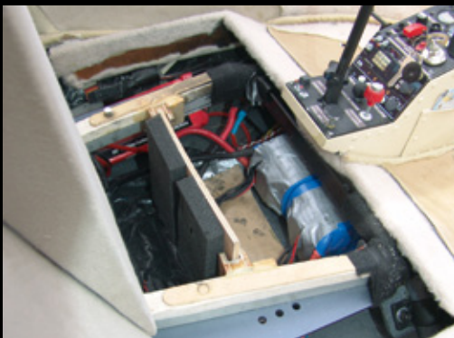
Die demontierte Cockpit-Bodenplatte gibt den Zugang zum Rumpfbau frei, in dem unter anderem die beiden 6s-LiPos verstaut sind
