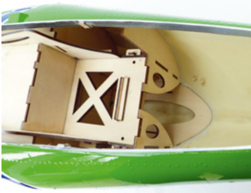
Blick auf den hinteren Teil der Spanten-Konstruktion. Um die Kräfte gleichmäßig im Rumpf einzuleiten, verläuft der untere Spant im gesamten Bodenbereich
