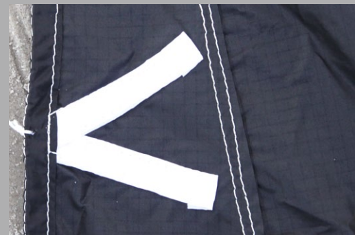
Verstärkung für die Waagepunkte am Flügelende
