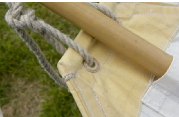
Für hohe Belastung wird die Öse umnäht und der Segelabschluss gesichert
