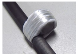
4. Kitt mit Glasfasersträngen umwickeln, bevor er hart wird. Nach der Trocknung satt mit flüssigem Epoxy-Kleber tränken
