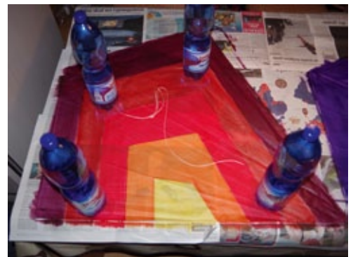
Wichtig ist, darauf zu achten, dass das Segel möglichst plan aufliegt und die Farbe vor dem nächsten Arbeitstag durchgetrocknet ist
