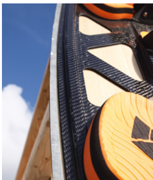
Ausgesteiftes Carbon nimmt die Kräfte auf
