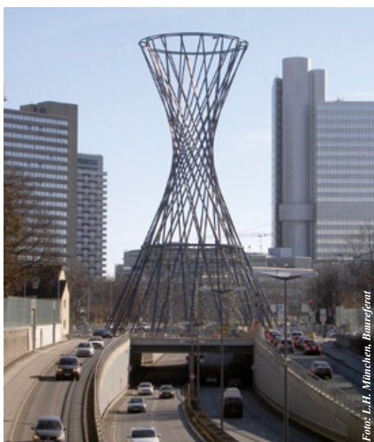
Kunst aus Karbonröhren: „Mae West“ von Rita McBride am Münchner Effnerplatz. Das Mittlere Stützgerüst wird noch entfernt
