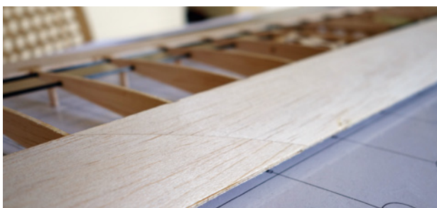
Die Beplankung muss schlüssig mit der Nasenleiste erfolgen
