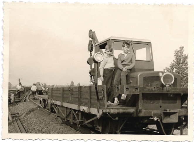
So gefiel es Karl-Robert am besten – mit seinem Vater auf einer Eisenbahnbaustelle. 60 Jahre ist dieses Bild alt. Karl-Robert sitzt hier auf der Motorhaube eines Baufahrzeuges der DB – heute undenkbar
