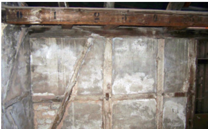
Ein aktuelles Foto aus dem Inneren der ersten Fabrik von Kämmer & Reinhardt: Hier war das einstige Lager, zu erkennen an den dazu gehörenden Zahlen auf einem Dachbalken
