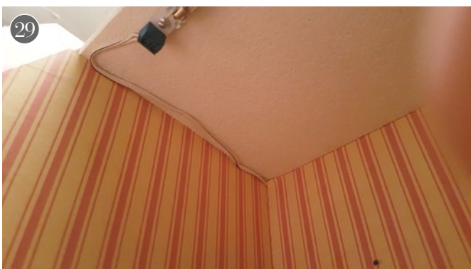
29 Nun werden in die Rückwand der Box einige Bohrungen eingebracht. Zunächst eine, um das Kabel der indirekten Beleuchtungsleiste nach hinten zu führen ...
