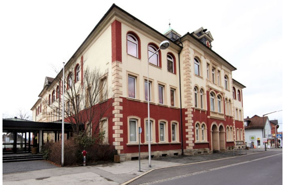
In der Schule an der Heubischer Straße war bis 1907 die Zeichen- und Modellerschule untergebracht, heute dient sie als Grundschule
