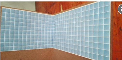
8 Im nächsten Schritt wird die Fliesenfolie an der Trennwand sowie an der Rück- und Seitenwand der Box verklebt. Auch hier gilt: Nahtlos arbeiten, da es keine Fußleisten sind
