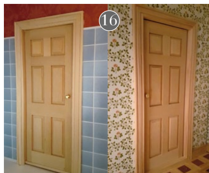
Anschließend wird in die Trennwand die naturfarbene Tür eingesetzt. Auf der anderen Seite wird der Rahmen komplettiert und im Schlafzimmer kommen ebenfalls naturfarbene Fußleisten an die Wand
