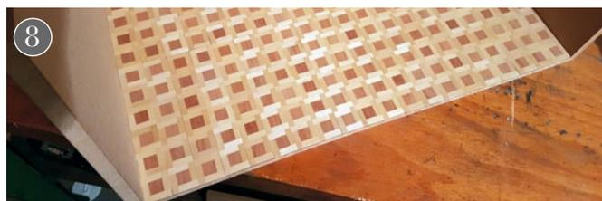
Nach dem Trocknen wird das Parkett angeschliffen. Der Staub setzt sich in den zwangsläufig entstehenden Ritzen ab und schließt diese
