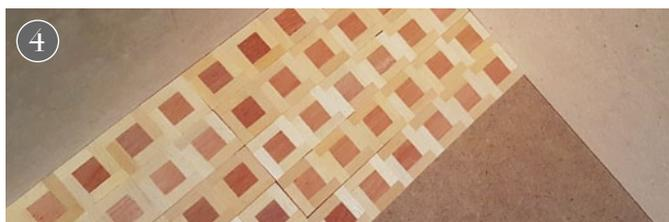
Zwischenräume zwischen den einzelnen Parkett-Elementen sind normal und verschwinden nach dem Schleifen und Lackieren vollständig
