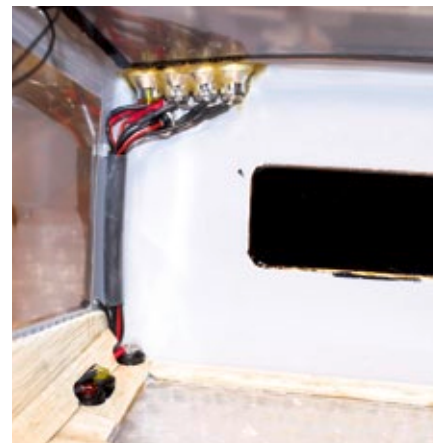
Eine knifflige Aufgabe kurz vor der Vollendung: Die Kabelverlegung in der Kabine
