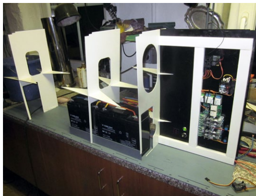
Mit herkömmlichen LiPos ist es bei der Asphaltmischanlage nicht getan. Hier kommen größere Kaliber zum Einsatz
