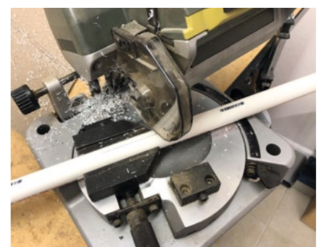
Winkelgenaues Trennen der Rohre mit der Kappsäge
