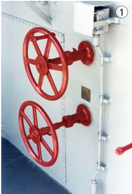
Selbst ein Kabel ist auf vier Brücken gelagert. Unten erkennt man die Durchführungsbuchse
