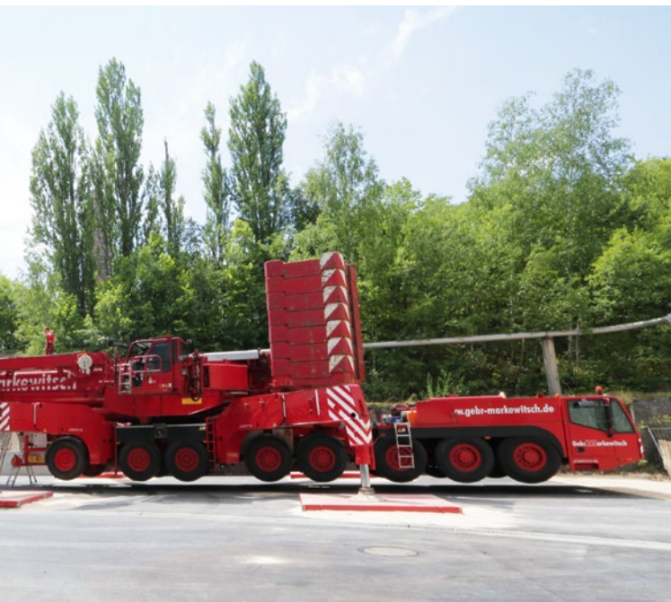
Für die Montage des Gittermastauslegers benötigt man beim Terex Demag AC500-2 einen weiteren Autokran
