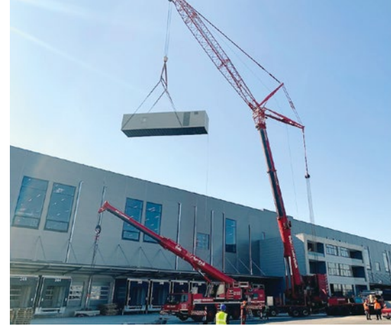
Wo der Teleskopkran an seine Grenzen kommt, steht der Gittermastkran bereit
