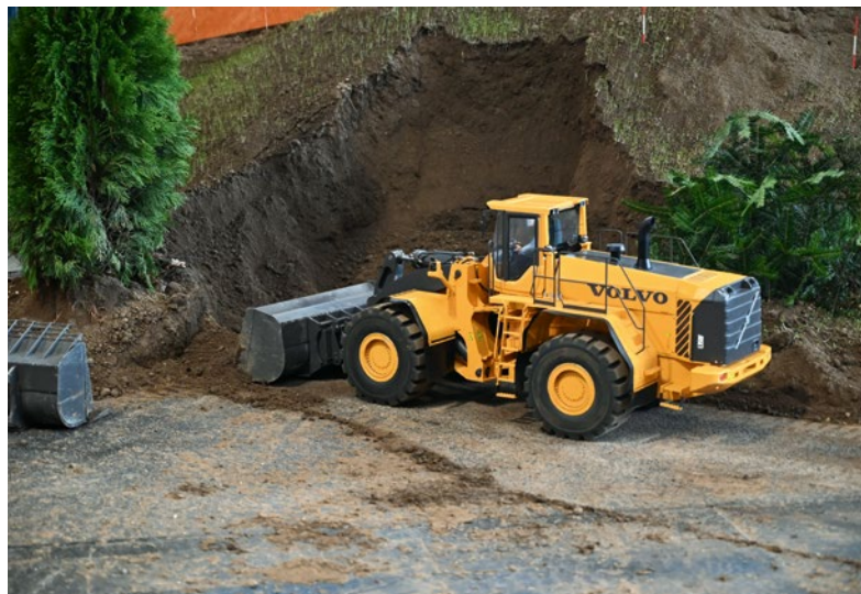
Reichlich Erde wurde unter anderem von diesem Volvo Radlader abgetragen
