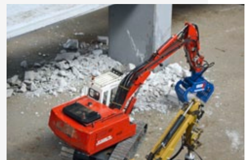
Auch zahlreiche Baumaschinen wie beispielsweise dieser Abbruchbagger waren vor Ort im Einsatz
