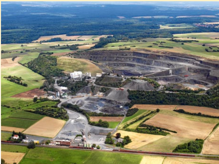
Europas größter Basalttagebau in Nieder-Ofleiden ist Veranstaltungsort der Steinexpo
