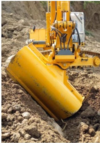
Böschungskanten und andere Geländeübergänge sind mit dem voll funktionsfähigen Likufix-System sehr präzise realisierbar
