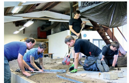
Im Sommer 2015 wurde der Parcours im Erdgeschoss völlig neu aufgebaut
