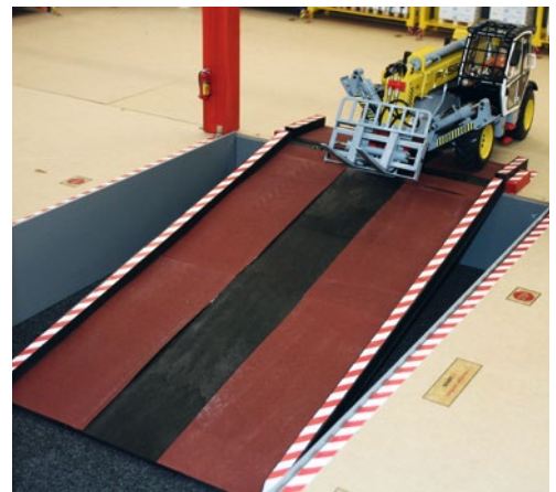
Mangels Platz an den Seiten musste die Rampe in die Ladezufahrt integriert werden. Sie kann mit einem Handgriff auf- und abgebaut werden
