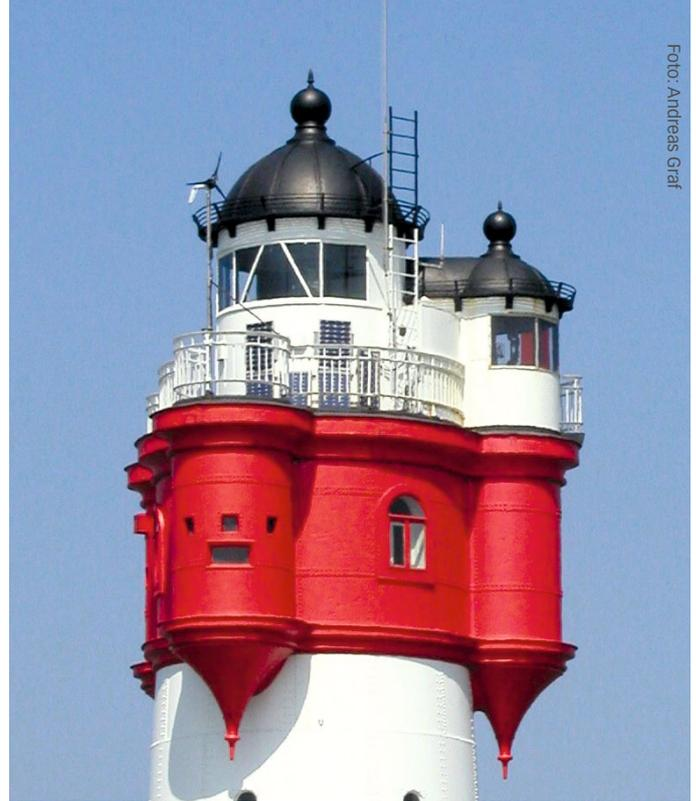
**Details am Original – Alle fünf Jahre muss der Anstrich des Turms komplett erneuert werden. Dazu wird die Außenhaut im Vorfeld von Salzkristallen befreit, anschließend wird ein Rostschutzlack aufgetragen**
