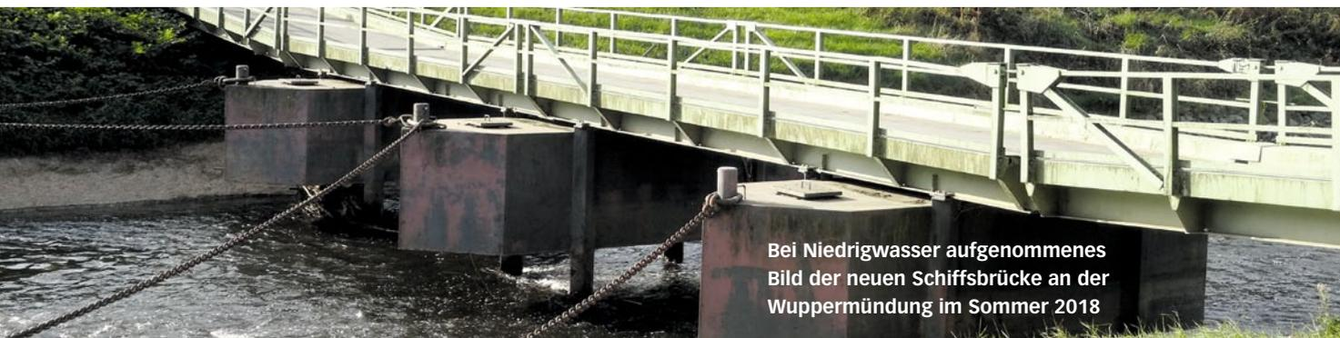
Bei Niedrigwasser aufgenommenes Bild der neuen Schiffsbrücke an der Wuppermündung im Sommer 2018
