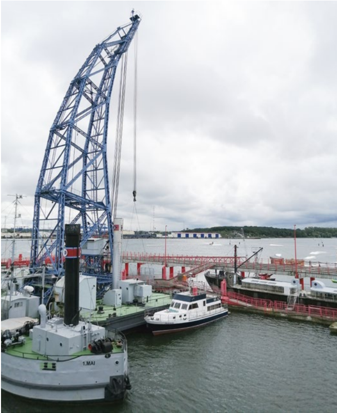
Der Schwimmkran LANGER HEINRICH, davor das Hebeschiff 1. MAI
