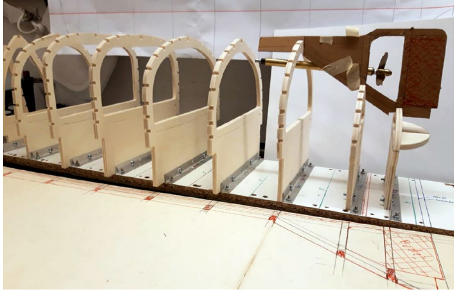
Vor dem Beplanken wird eine Schablone für die Ruderanlage eingepasst
