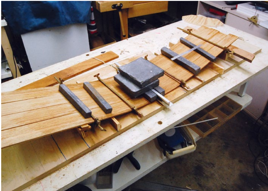
Die Bodenplanken werden in Form gebracht. Dafür wurde das Baubrett entsprechend präpariert
